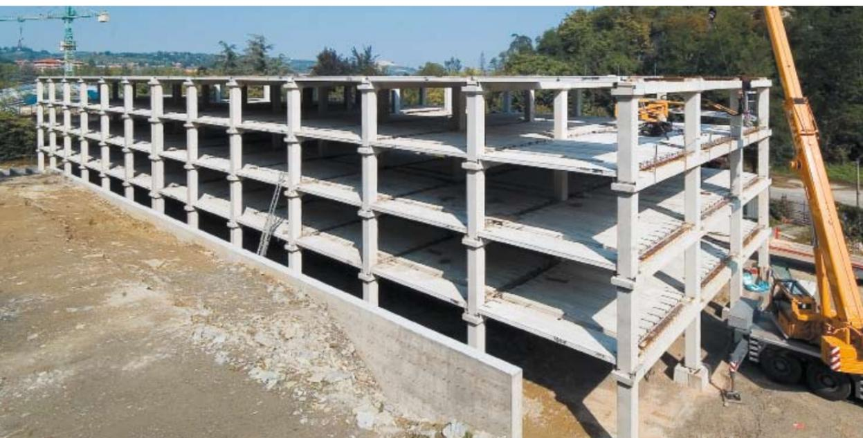
**EUROCAP** produce e realizza strutture multipiano utilizzando un sistema costruttivo costituito da pilastri, travi, solai; fondato sulla tradizione architettonica della prefabbricazione e modernizzato attraverso l'adozione di scelte tecnologiche d'avanguardia.
